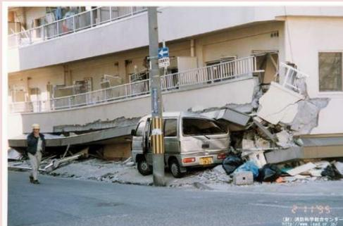
☐基礎の著しい破壊、上部構造との著しいずれがある
